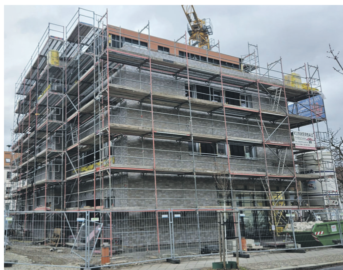
Die Baumaßnahmen in Sömmerda schreiten voran.
