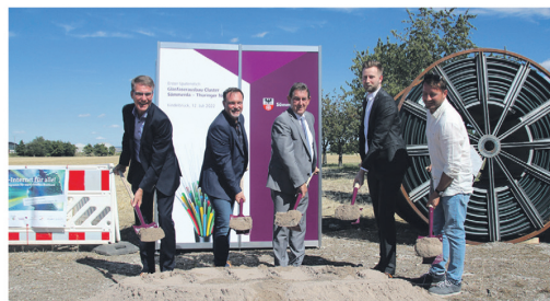
2022 erfolgte in Kindelbrück der Spatenstich für den geförderten Breitbandausbau im Nordkreis.
