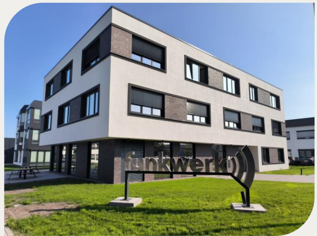
Foto: Funkwerk Systems GmbH
